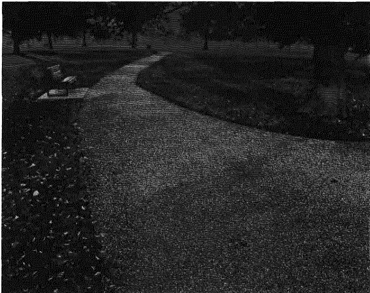
Su uno strato di poliuretano liquido si iniettano le particelle luminose (fissate poi con resina) che assorbono energia dai raggi ultravioletti.
